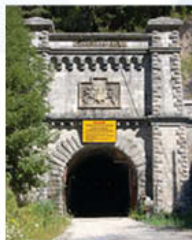
Figura 3. Entrada al túnel de Canfranc
